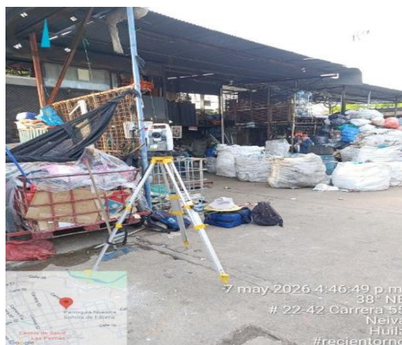
Figura 14 Levantamiento topográficos dentro de la ECA
