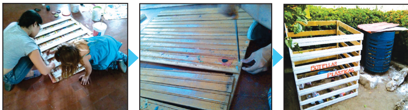
Imagen 3. Construcción del cajón de reciclaje para el esquema del Biomodelo Sostenible
